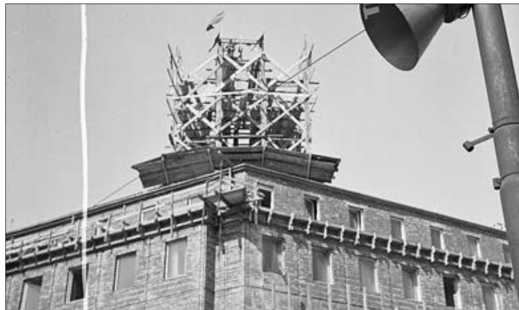
Widok budynku w stanie surowym podczas wykonywania prac przy elewacjach oraz przy montażu reklamy neonowej - globusa, 1951 r. (źródło: NAC; http://fotopolska.eu )
