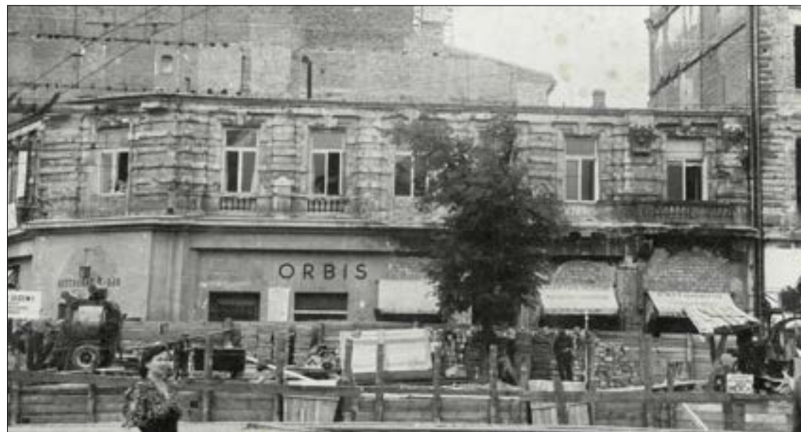
Widok kamienicy od strony Al. Jerozolimskich tymczasowo obniżonej do czasu rozpoczęcia budowy nowego budynku biurowego. 1948 r. Na pierwszym planie widoczna budowa drugiego tunelu linii średnicowej. (źródło: ze zbiorów M. St. Warszawy - Biuro Organizacji Urzędu, Wydział Archiwum)
