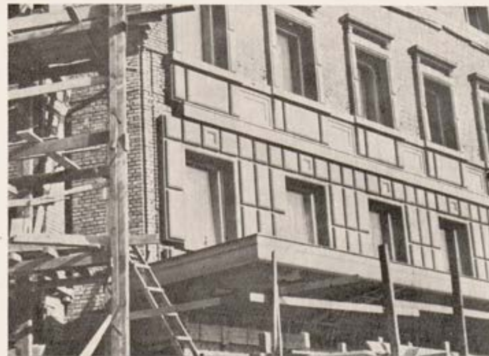
Pierwsze i drugie piętro „Orbisu”, mimo że pod względem wykonawstwa należą do „apresfabrykatów”, formą swą stanowią przyczynek dla rozwoju architektury naprawdę prefabrykowanej. Fragment brzozy przy gołym murze zdradza sposób montażu przez aplikację.
