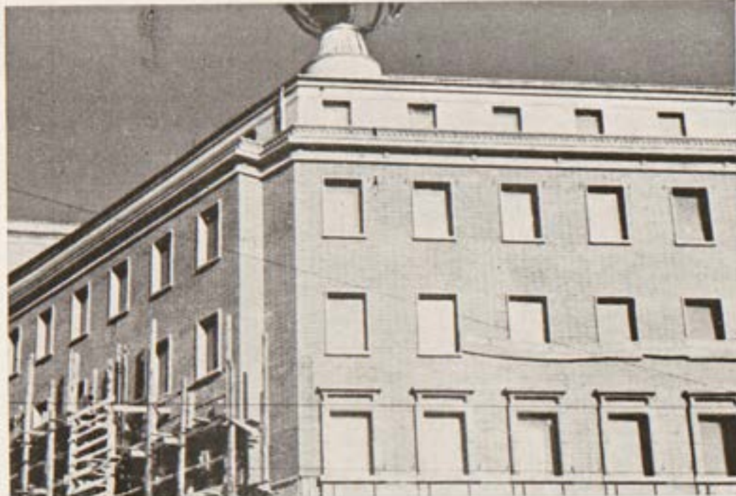
Górne piętro „Orbisu” obłożone cegielką prasowaną, niesłusznie nazywaną prefabrykatem. Prześwitowa balustrada nad gzymsem głównym jest natomiast w charakterze właściwej prefabrykacji.
