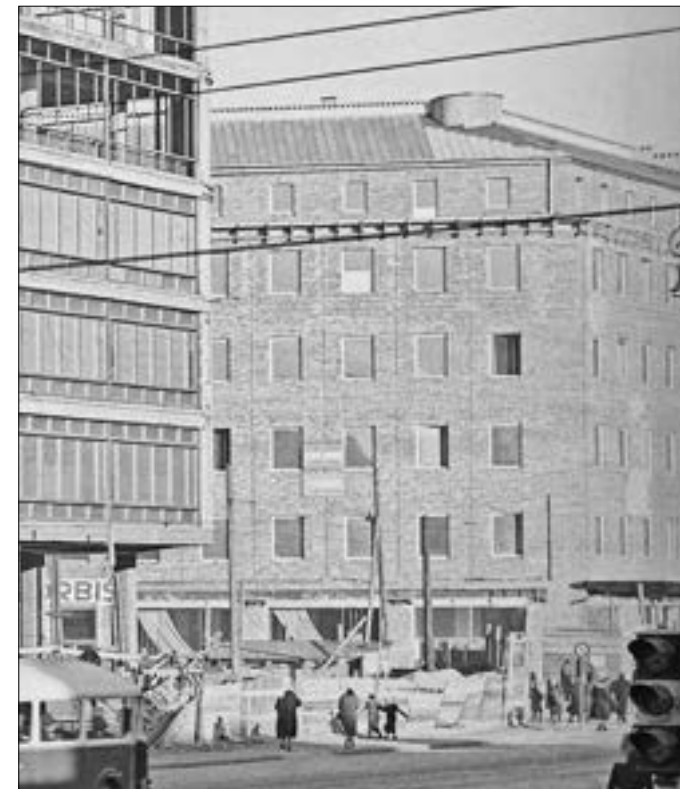
Budowa budynku biurowego przy Brackiej 16, widok od strony południowej i Al. Jerozolimskich. Widoczny stan surowy budynku. Zdjęcie z końca 1950 r. (źródło: NAC; http://fotopolska.eu )
