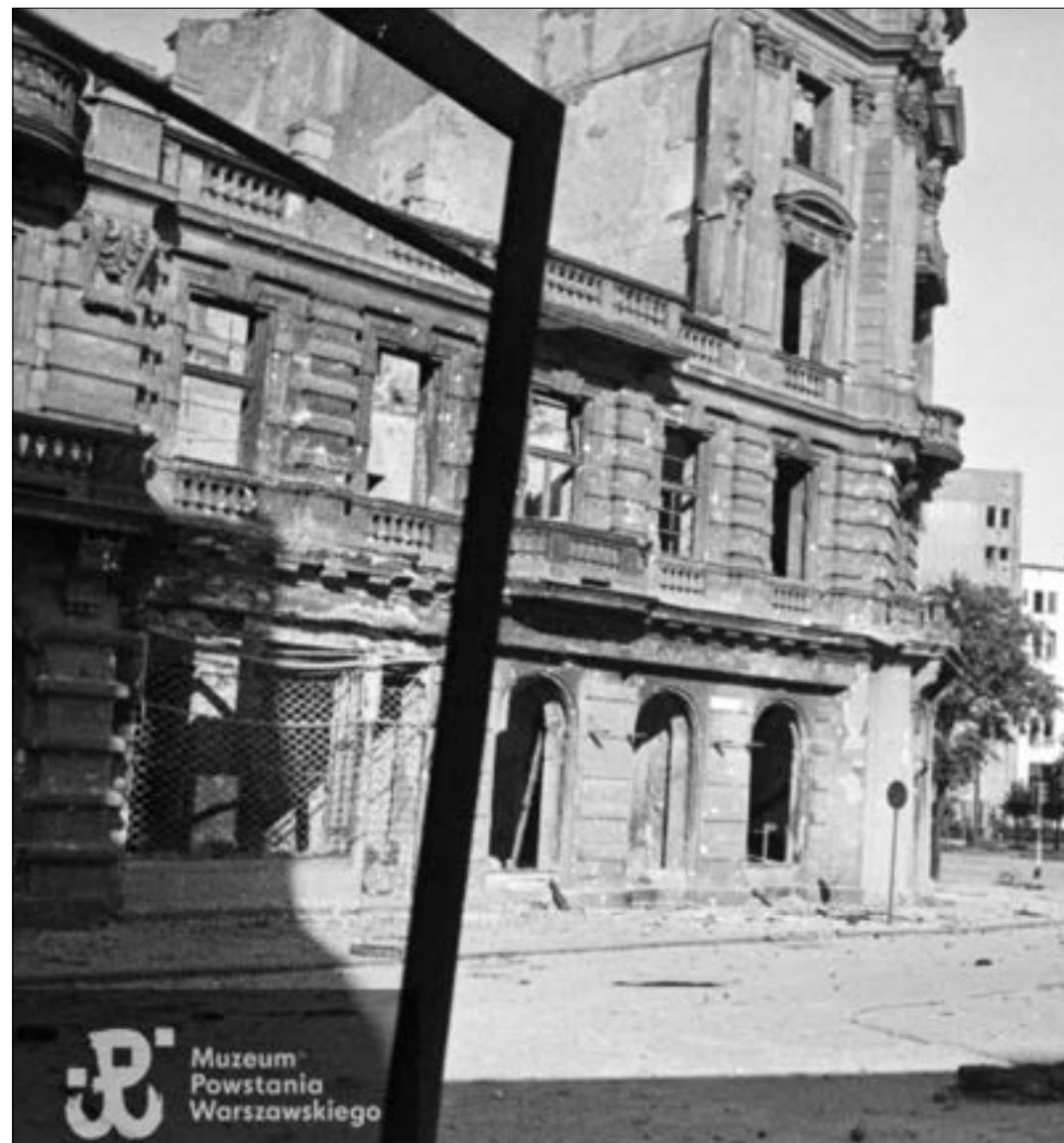
Zdjęcie z sierpnia 1944 r. Widok kamienicy przy Brackiej 16 przy skrzyżowaniu z Al. Jerozolimskimi. Część kamienicy została uszkodzona najprawdopodobniej po nalotach radzieckich w latach 1941-1943. (fot. Joachim Joachimczyk; źródło: https://www.1944.pl )
