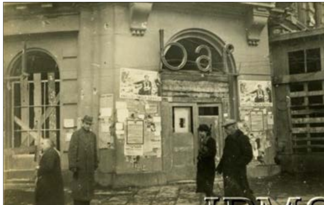
Wypalona kamienica przy ul. Brackiej 16, widok naroża w parterze, z wejściem do baru przy restauracji „Cristal”. Październik 1939 r. (Archiwum Fotografii Ośrodka KARTA; źródło: https://foto.karta.org.pl )
