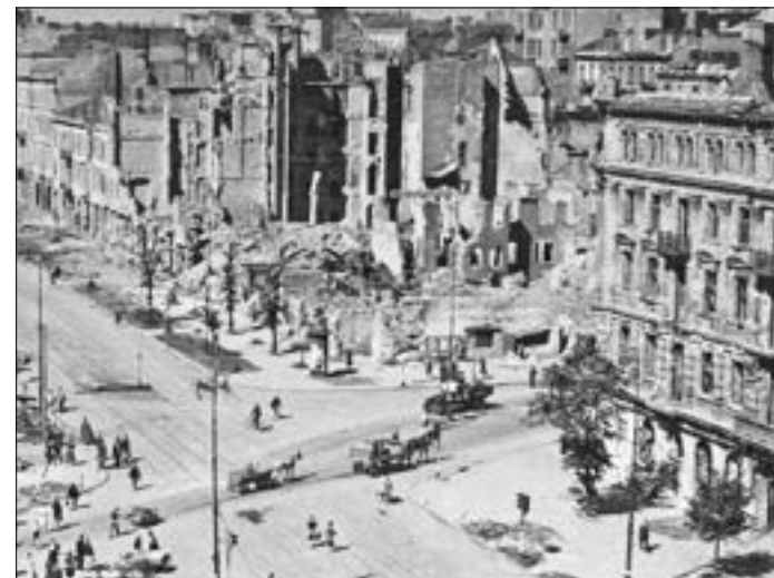
Al. Jerozolimskie, po prawej stronie widoczny fragment kamienicy przed wyburzeniem do wysokości 2 kondygnacji, 1945 r. (fot. Zofia Chomętowska, http://fotopolska.eu )
